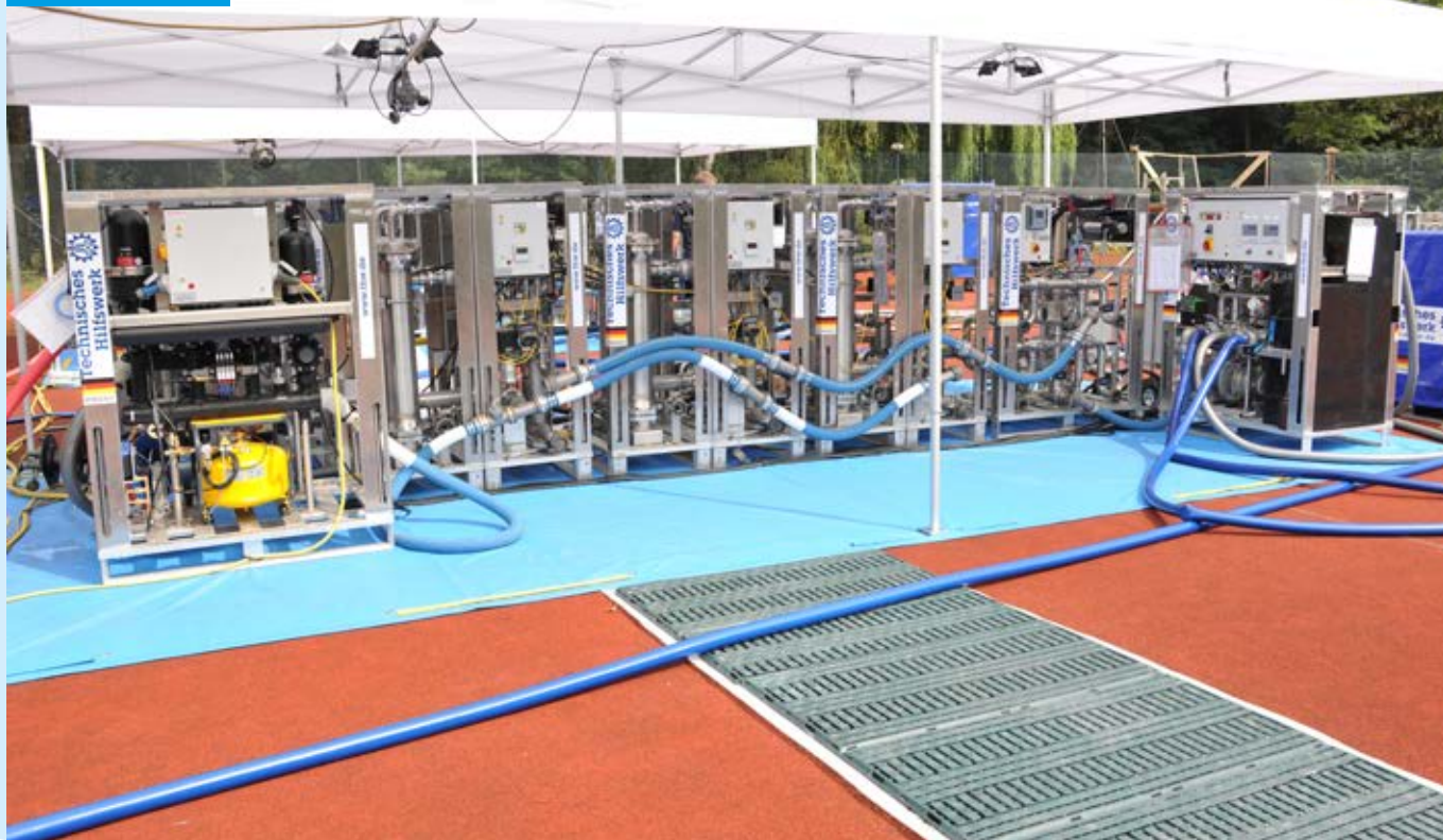
Beim Betrieb einer Trinkwasseraufbereitungsanlage (hier BuJuLa 2014) überprüfen Trinkwassertenant_innen, ob das Wasser sauber ist.
